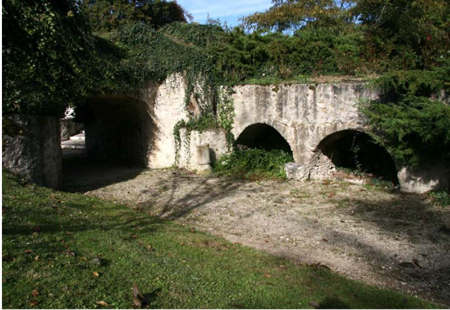
Fig. 18 : Propriété de « La Voûte » ; les 3 arches ; celle à gauche ouvre vers l'ancienne fosse qui accueille aujourd'hui la piscine. Les deux arches de droite sont aujourd'hui fermées par une maçonnerie.
